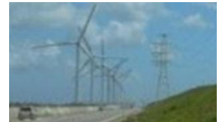
波崎海岸沿いの風力発電設備
