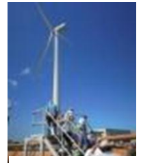
風力発電設備
