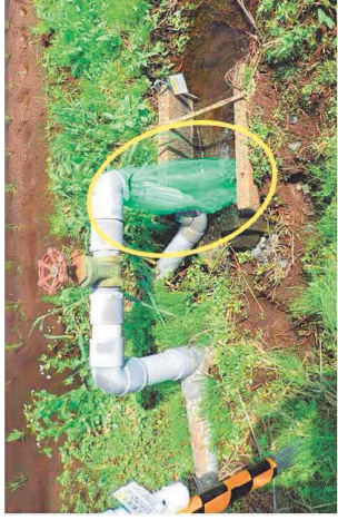
給水栓の口に収穫ネットを被せ流入を防止
