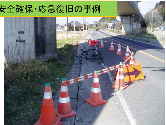
茨城鹿島線(鉾田市二重作) 道路陥没箇所へのバリケード設置による安全確保
