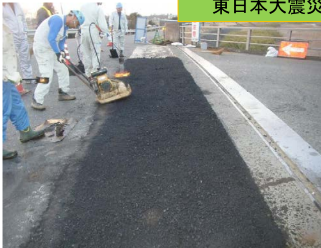
土浦境線(土浦市虫掛) アスファルト合材舗設による段差解消のための応急対策
