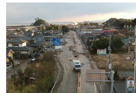
東日本大震災で国道6号が通行不能
