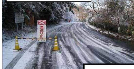
朝日峠の通行止めの状況
