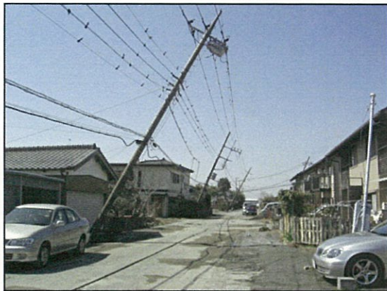
傾斜した電柱
