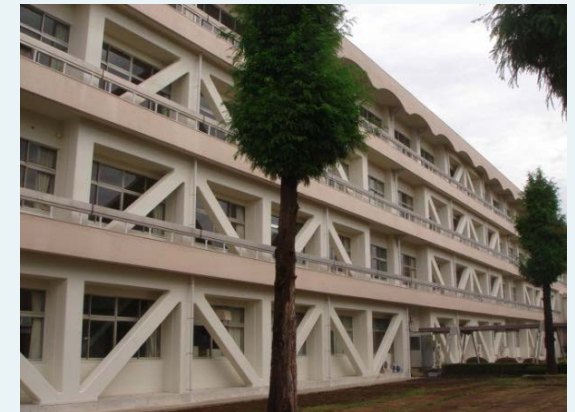
県立高等学校(平成22年10月工事完了)
