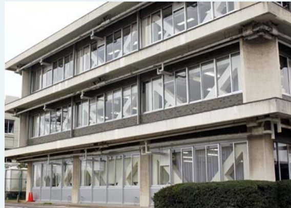
事務所(平成22年3月工事完了)
