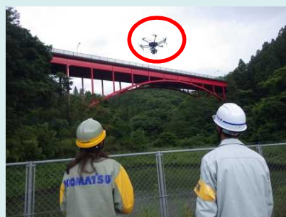
ドローンによる被災状況の調査訓練 【コマツ茨城(株)】
