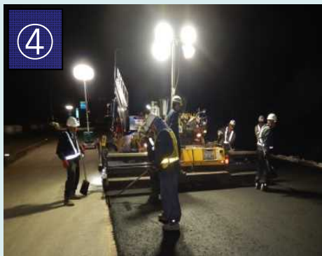
④ 24時間体制の応急復旧工事 【(一社)茨城県建設業協会】
