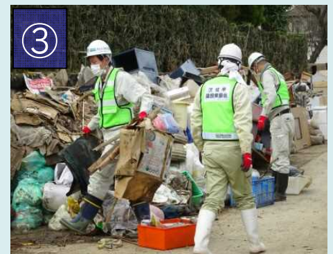
③ 災害ごみの撤去作業 【(一社)茨城県建設業協会】
