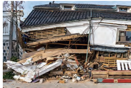
地震による被害例 (能登半島地震)
