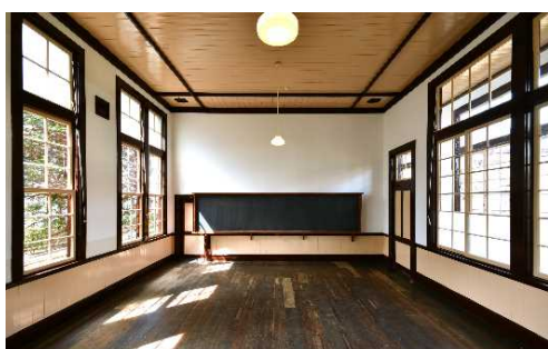
教室（内部改修，白色の壁は漆喰）
