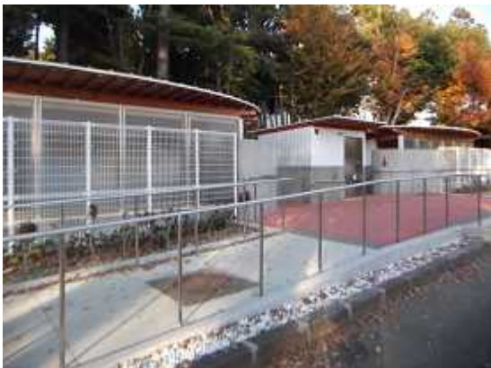
第6屋外トイレ 外観
