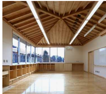
普通教室（小屋組みに県産木材を採用）
