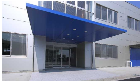
エントランス（床に県産石材を採用）
