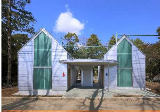
第7屋外トイレ 外観（第8もほぼ同様）
