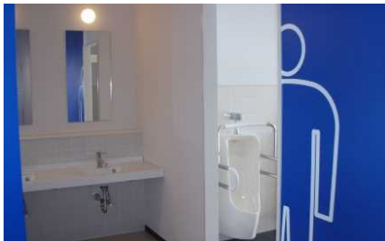
男子トイレ（腰壁上に珪藻土を採用）
