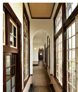
廊下（内部改修，白色の壁は漆喰）
