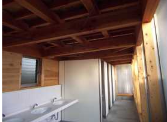
第6屋外トイレ 内観
