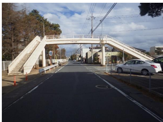
鋼橋（平泉歩道橋、国道124号、1970年架設）
