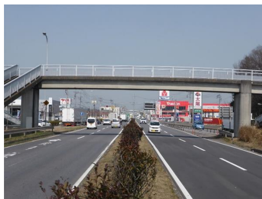
PC橋（谷和原歩道橋、国道294号、1980年架設）
