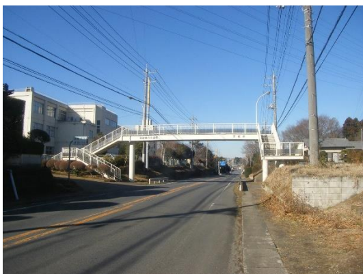
旧道を跨ぐ歩道橋 (常陸藤沢歩道橋、国道125号、1968年架設)
