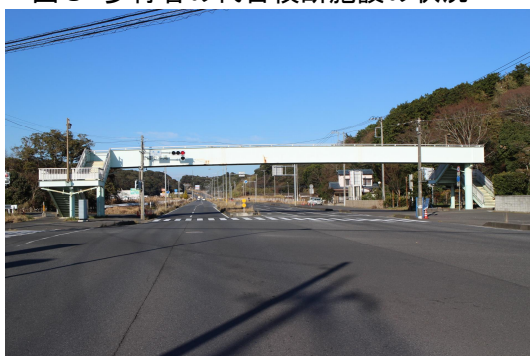
直下に横断歩道がある歩道橋 （木滝歩道橋、国道124号、2001年架設）
