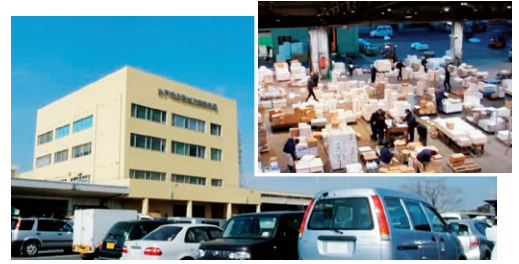
水戸市公設地方卸売市場を洪水被害から防御
