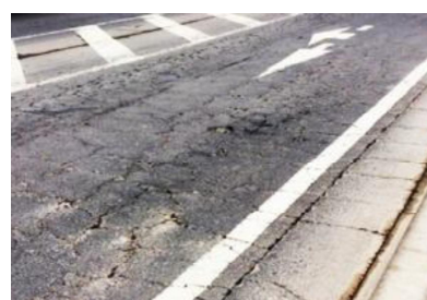
舗装修繕 茨城鹿島線(鹿嶋市)
