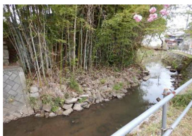
護岸整備 観音川(桜川市)
