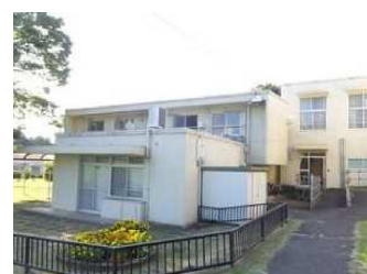
老朽化が進む入所施設
