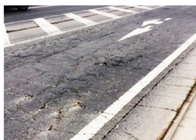
舗装修繕 茨城鹿島線(鉾田市)
