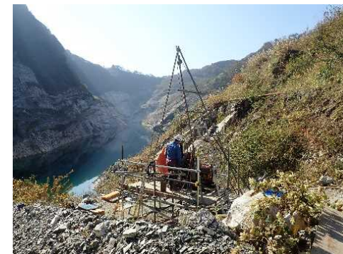
ボーリング調査作業状況
