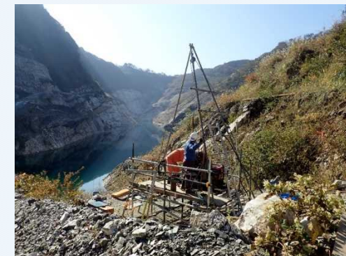
ボーリング調査の様子
