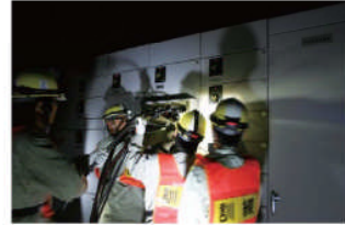
電源盤へのケーブル接続(夜間)
