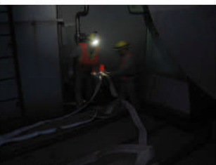
直接注入専用配管接続(夜間) (LPCS)
