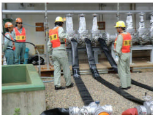
大容量送水システム既設配管接続 (RHRS)
