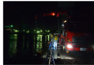
大容量送水システムポンプ設置(夜間)
