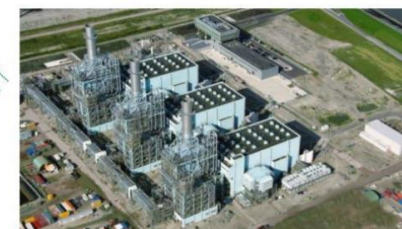
Vattenfall's gas power plant Magnum. (Photo: Koox Boertjens / Vattenfall)
