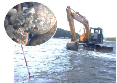
重機を活用したアユの産卵場造成
