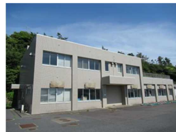
水産加工実験棟
