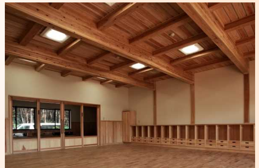
▲大断面集成材の現し仕上
