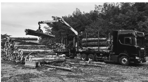
写真-3 中間土場活用によるC材の搬出状況
