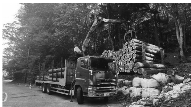
写真-2 山土場におけるA・B材の搬出状況
