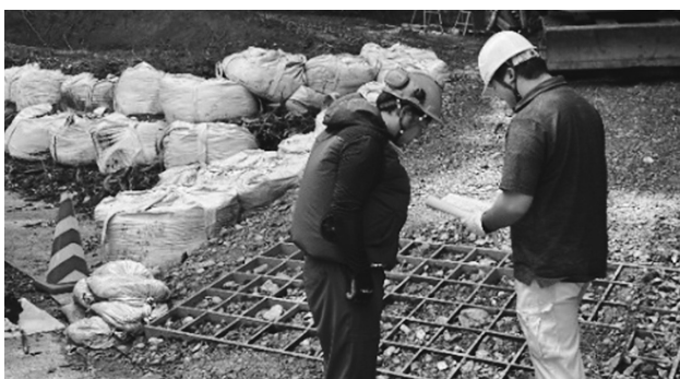
写真-1 鋼製枠等を活用した作業道作設の指導
