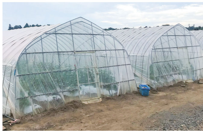
測定パイプハウス:幅5.4m×長さ50m(写真左:塗布あり、右:無処理)
