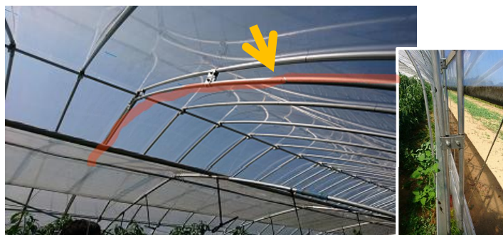
図-36 ダブルアーチパイプで強化
