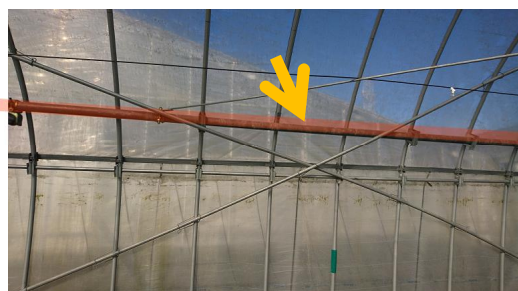
図-29 足場用直管パイプによる側面補強
