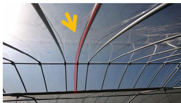
図-37 アーチパイプ増設による強化
