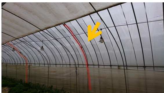
図-33 ダブルアーチパイプによる強化
