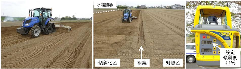
図1 傾斜化圃場の造成作業(左・中)および発光機の設定(右)
