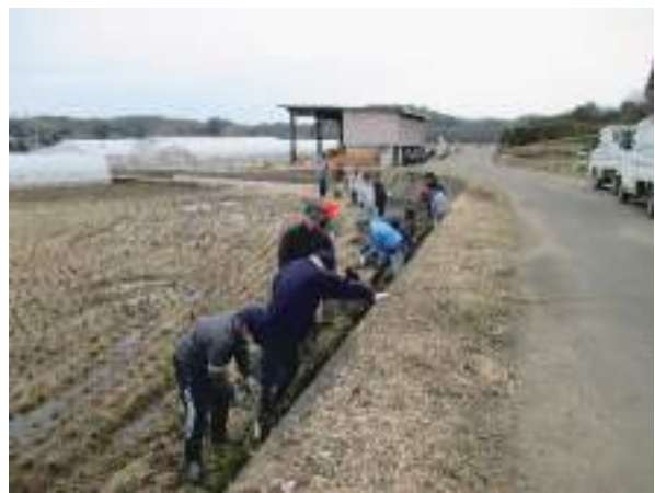
地域住民による泥上げ作業
