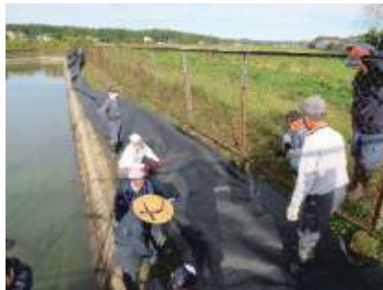
調整池法面への防草シート取付け作業
