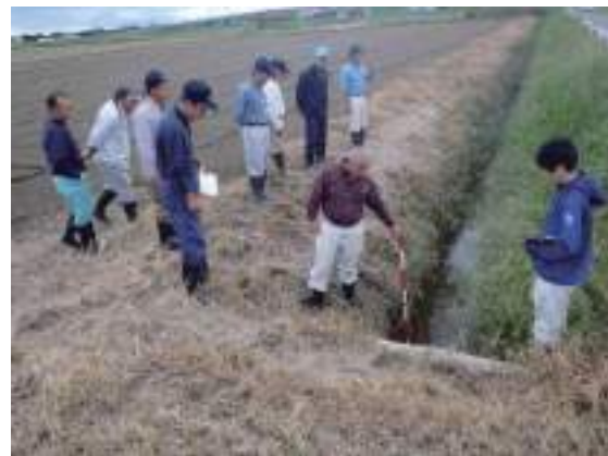
農家・土地持ち非農家にて施設の点検
