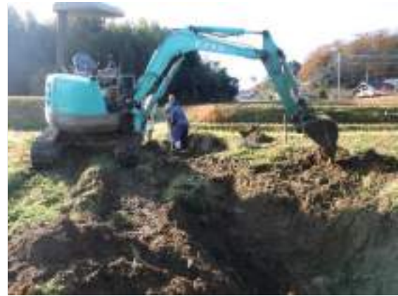
崩落水路の復旧作業
