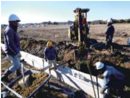
自主施工による更新
