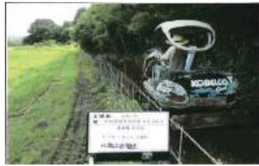
水路土砂撤去
