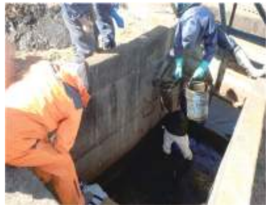
水路の泥上げ
