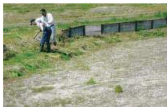
水路の清掃作業
