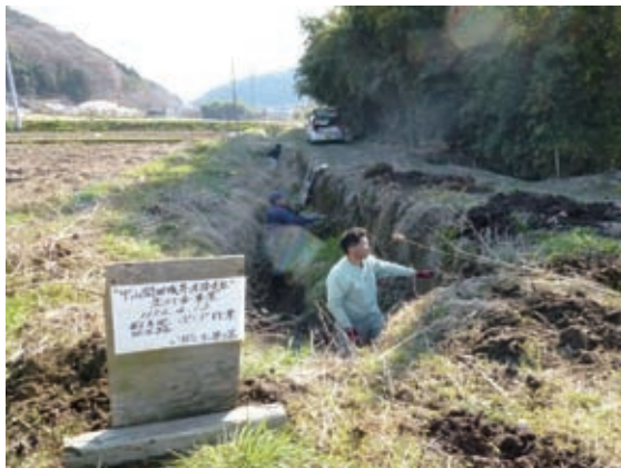
○用水路の清掃（土砂撤去）
