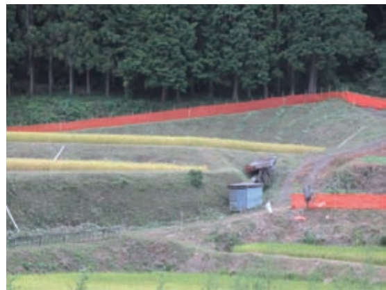
○適正に管理されている急傾斜法面
