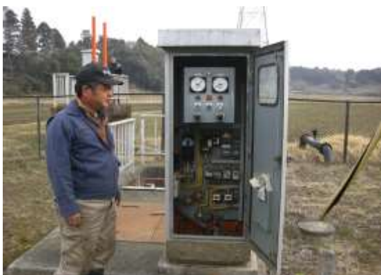
①施設の点検
