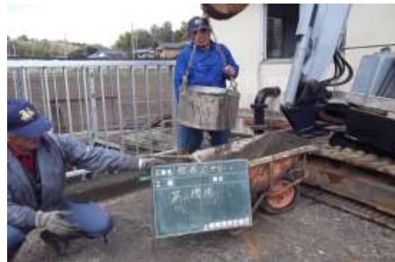
④機場泥上げ
