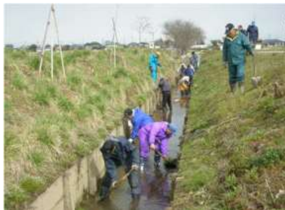
②水路の泥上げ
