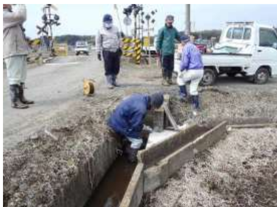
① 水路の補修
