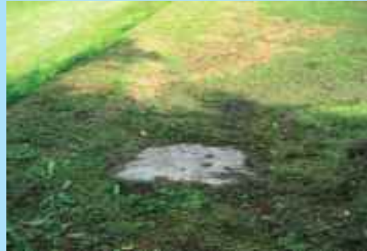
水田入り口のコン (クリート舗装 機械出入り時の 安全性確保)
