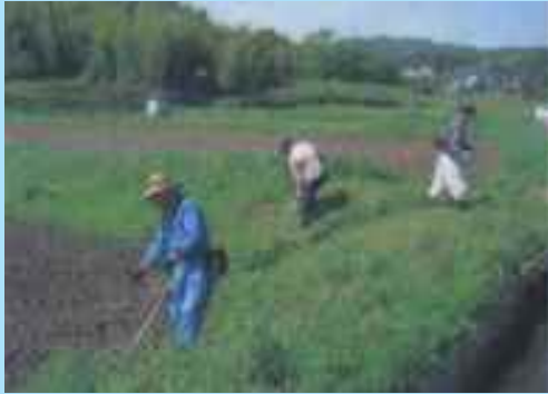
法面の草刈作業
