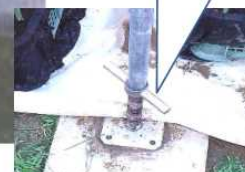
図 中柱による補強の様子
