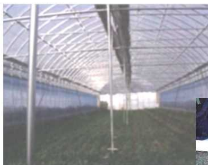
図 中柱による補強の様子
