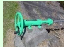
ゲート、バルブの更新
