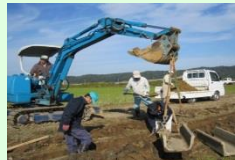
コンクリート水路の更新
