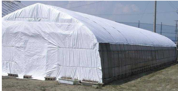
図1 不織布シート被覆状況
