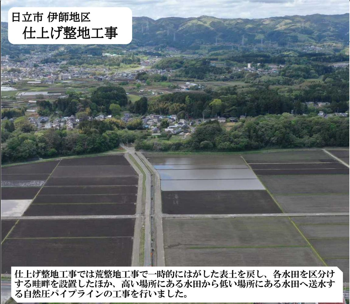
仕上げ整地工事では荒整地工事で一時的にはがした表土を戻し、各水田を区分けする畦畔を設置したほか、高い場所にある水田から低い場所にある水田へ送水する自然圧パイプラインの工事を行いました。
