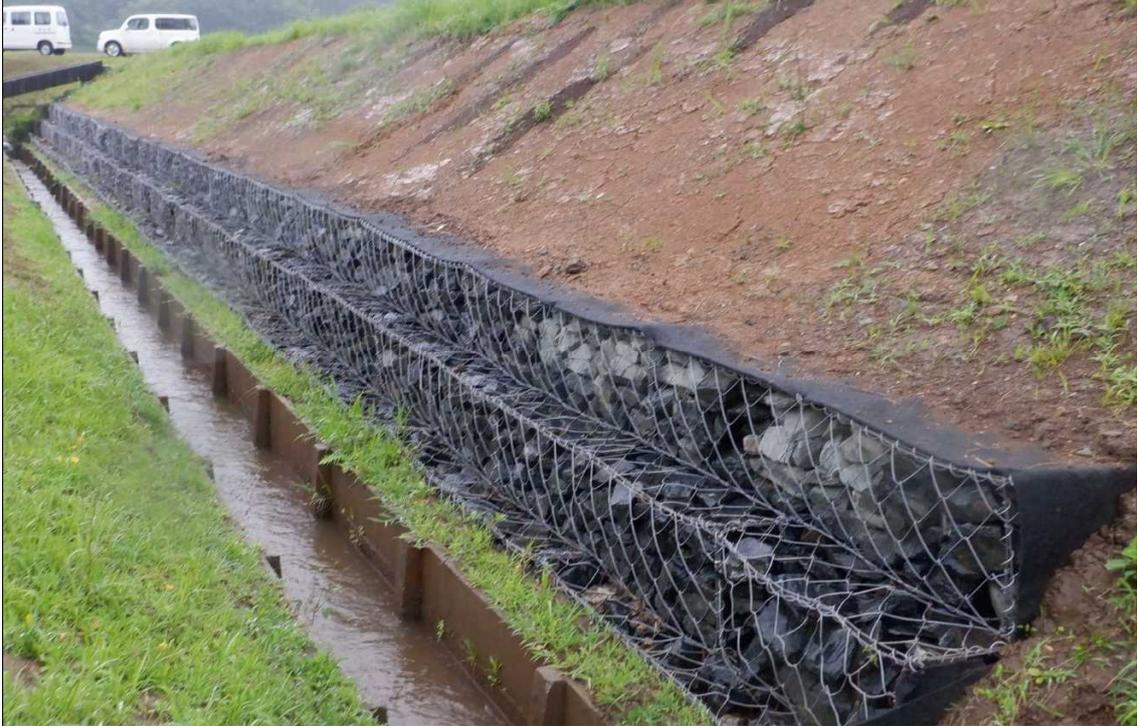
2023年度(令和5年度)9月8日の台風13号により被害を受けた箇所への復旧工事が完了しました。工事内容は崩れた田んぼ法面へのふとんかごの設置やため池法面に植生シートを張る等、多岐にわたります。
