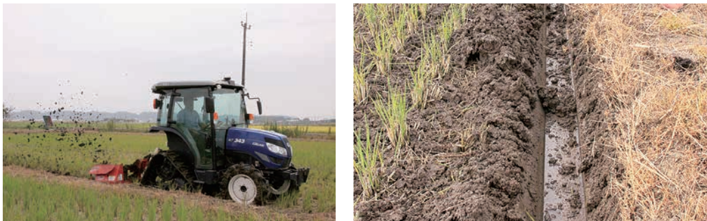
図3-2)-1 溝掘機による明渠施工の様子(左)、額縁明渠(右)
