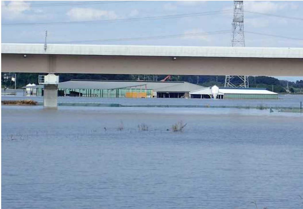
写真3 浸水した牛舎の様子
