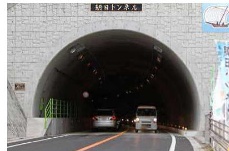
朝日トンネル
