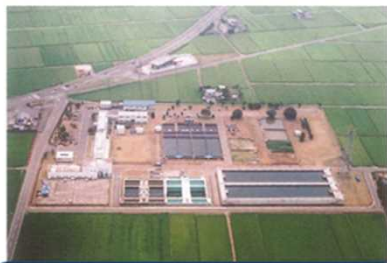
那珂川浄水場(那珂市西木倉)
