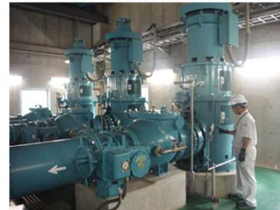
機械電気設備の点検業務
