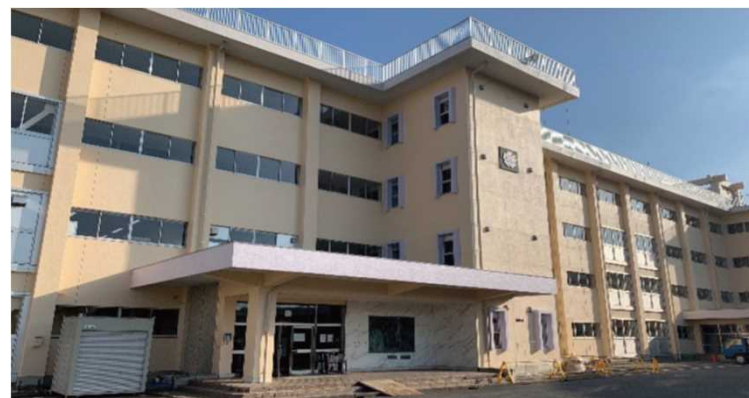
水戸商業高校管理教室棟 長寿命化改修工事
