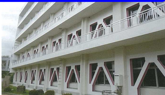
県有施設の耐震改修
