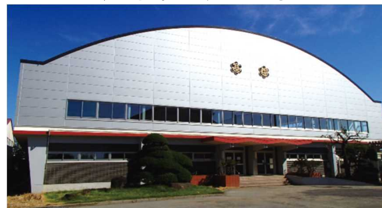
下館第一高校屋内運動場 長寿命化改修工事
