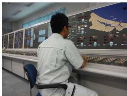
浄水場の運転監視業務
