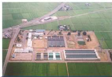
那珂川浄水場(那珂市西木倉)
