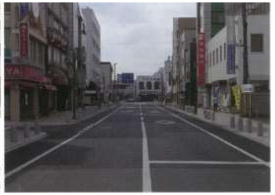
電線地中化 (後)
