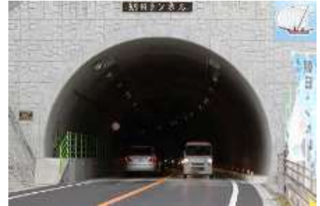
橋梁・トンネル整備による移動の円滑化
