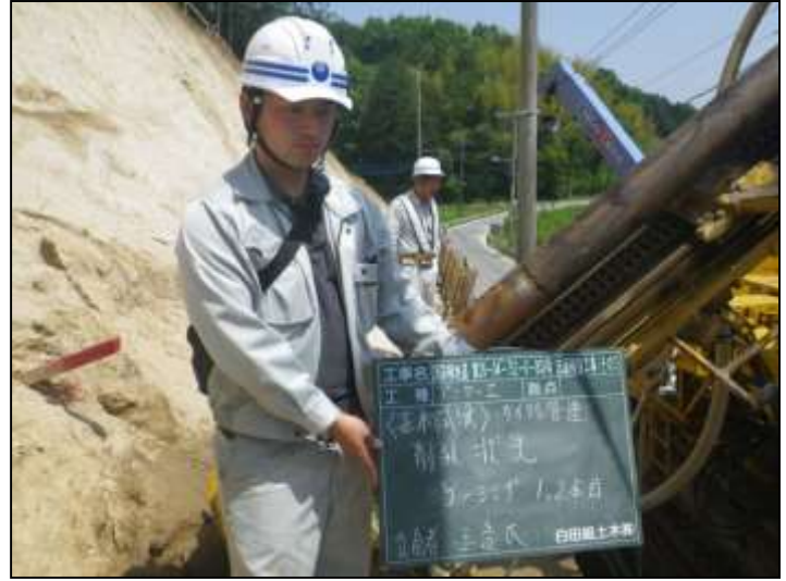
現場監督の状況
