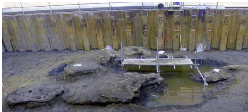
東西10m×南北8m×深さ2mのコンクリート様の塊
