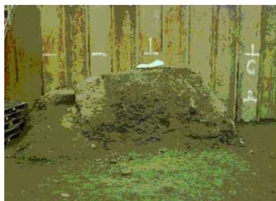
西側で発見されたコンクリート様の塊 (東西 1.2m×南北3m以上×深さ 1.5m 以上)
