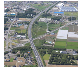
圏央道の4車線化
