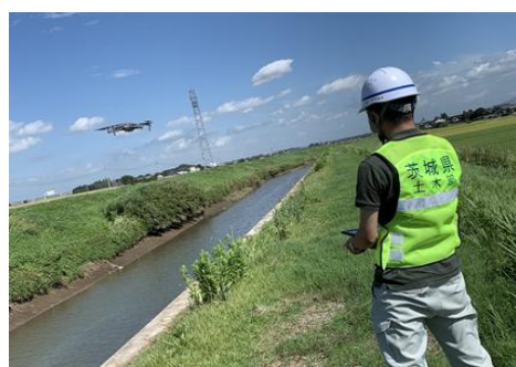
ドローンを活用した河川の点検
