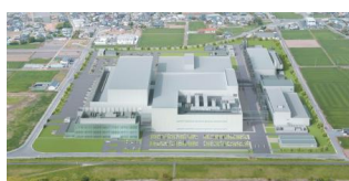
EL APSC 合同会社 下妻工場 (エステローダーグループ)
