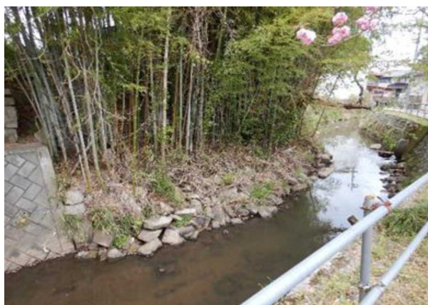
護岸整備 観音川(桜川市)
