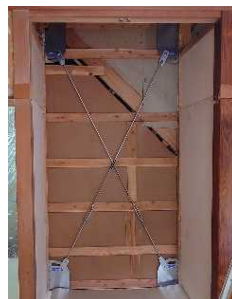
▲ブレース補強
