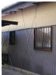
▲低コスト工法による補強（壁、天井撤去不要）
