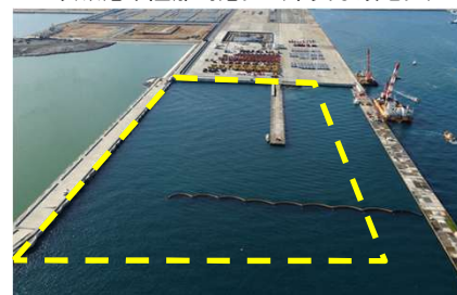
茨城港常陸那珂港区 (中央ふ頭地区)
