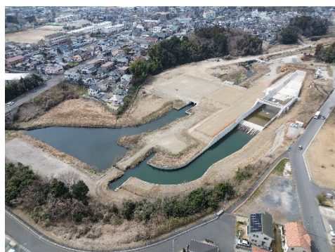
中丸川（調節池整備）
