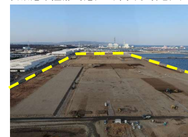
茨城港常陸那珂港区 (中央ふ頭地区)
