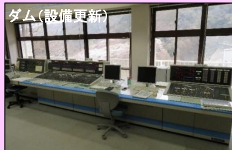
花貫ダム（高萩市）
