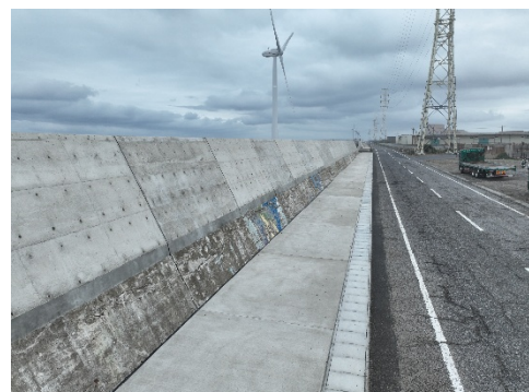
鹿島港（防潮堤整備）
