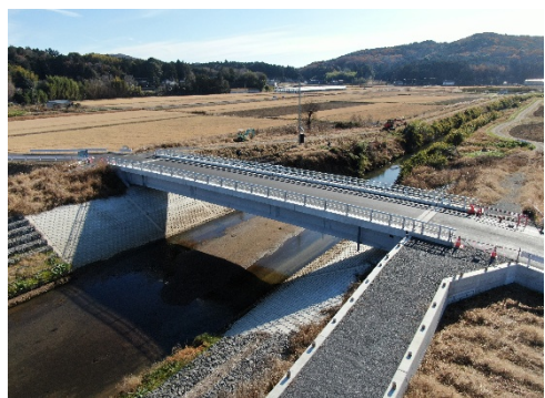
恋瀬川（河川改修）
