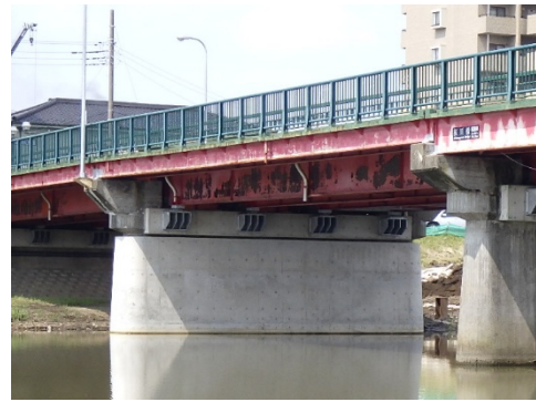
国道 125 号 桜川橋（耐震補強）
