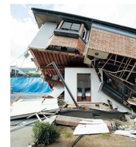
▲耐震シェルター事例
