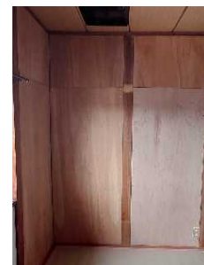
▲低コスト工法による補強（壁、天井撤去不要）
