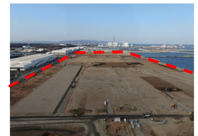
茨城港常陸那珂港区 (中央ふ頭地区)
