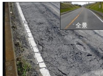
【路面再生】国道349号
