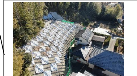
法面对策:武井1地区(鹿嶋市)
