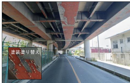
【橋梁修繕】水戸神栖線 梅香高架橋
