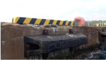
茨城港日立港区 (-9m岸壁)
