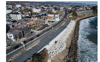
国道245号日立港区北拡幅
