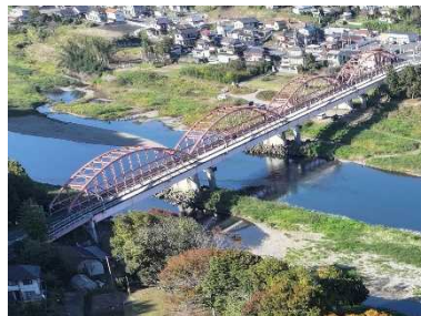
国道123号(那珂川大橋)
