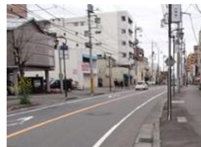
【無電柱化】取手東線
