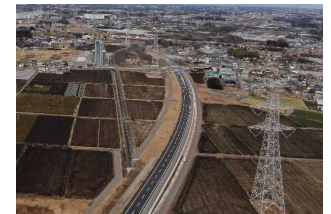
国道354号境岩井バイパス
