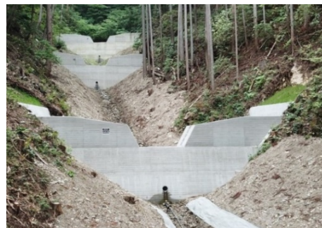
土砂流出防止のための治山ダム
