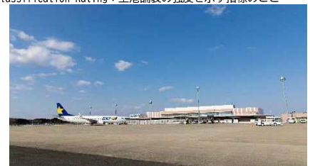
駐機場の舗装
