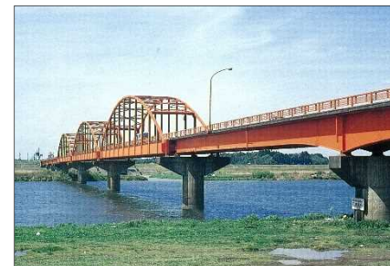
【橋梁耐震化】国道408号長豊橋
