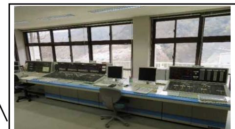
設備更新: 花貫ダム(高萩市)
