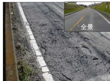
【路面再生】国道349号
