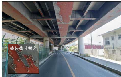
【橋梁修繕】水戸神栖線 梅香高架橋
