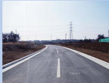
工事が進められる谷田部萱丸線の様子
