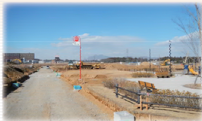
D街区の造成工事の様子
