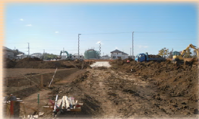
B街区の造成工事の様子
