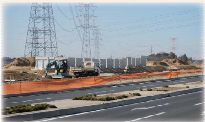
G街区の造成工事の様子
