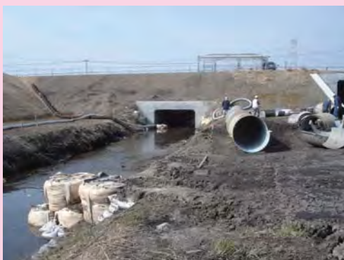
⑥西谷田川支川の改修工事の様子
