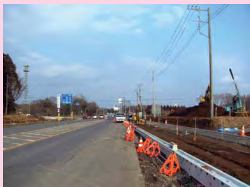
①土浦坂東線バイパスの道路工事の様子
