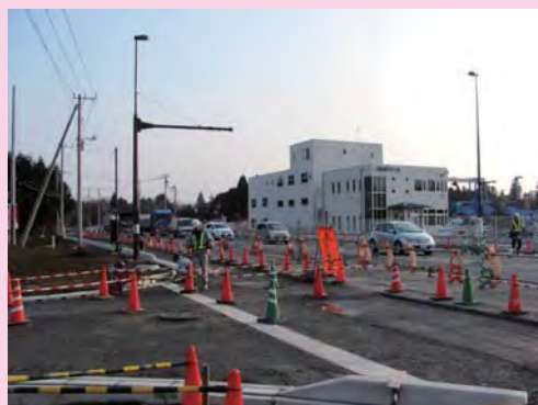
⑤共同利用街区南側のつくば真岡線バイパス交差点工事の様子
