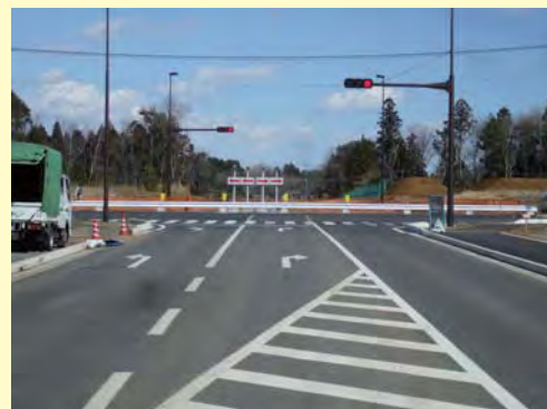
⑨開通したつくば真岡線バイパスに通じる13m道路
