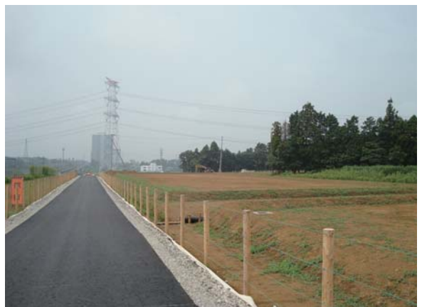
③ 谷田部萱丸線周辺の宅地造成工事の様子
