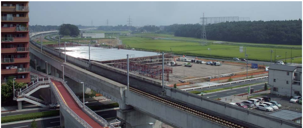
駅近隣に建設中の大型商業施設
