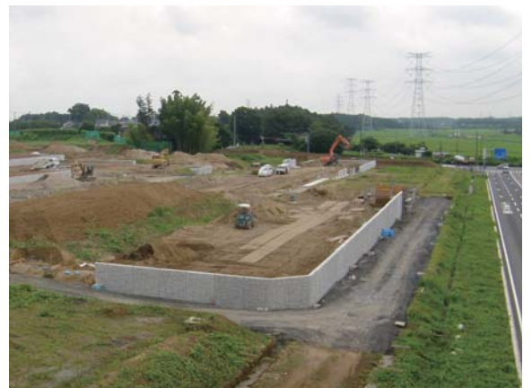
② 新都市中央通り線沿いの宅地造成工事の様子
